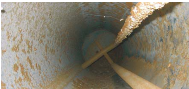
Serbatoio con vetrificazione screpolata con attacchi di ruggine.
