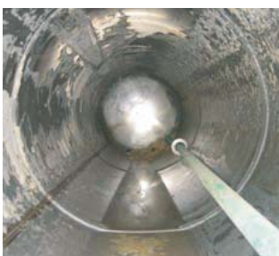
Serbatoio con vetrificazione screpolata con attacchi di ruggine.
